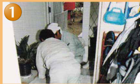
養生ボード敷き
