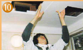
組立て据付工事
