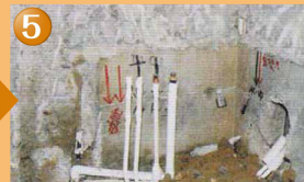
配線・配管完了
