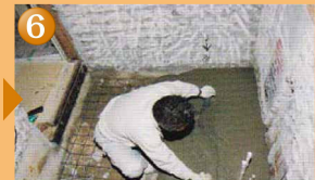
土間基礎工事
