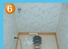
止水栓取り替え・水道を開く
