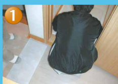
養生ボード敷き
