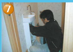
水栓・手洗いボール取付け
