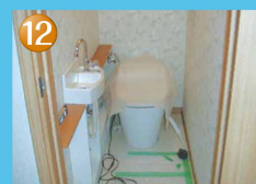
「全自動おそうじトイレ」据置き 設置完了
