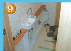
足元カウンター・トイレカウンター取付け
