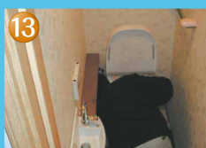
洗剤タンク取付け
