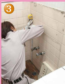
壁クロス貼り
