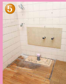
壁・床貼り完了
