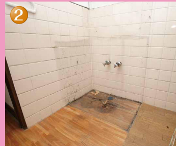
撤去後の配管状態
