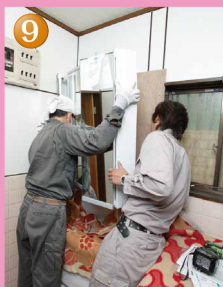
吊戸棚取付け
