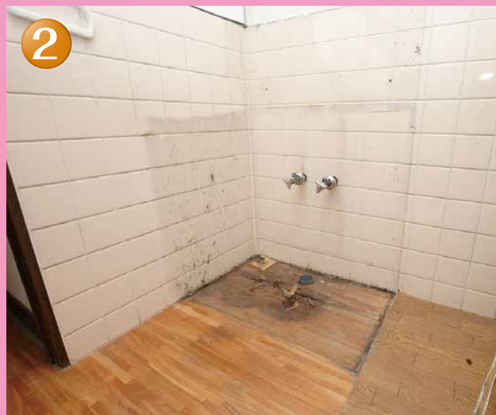
撤去後の配管状態
