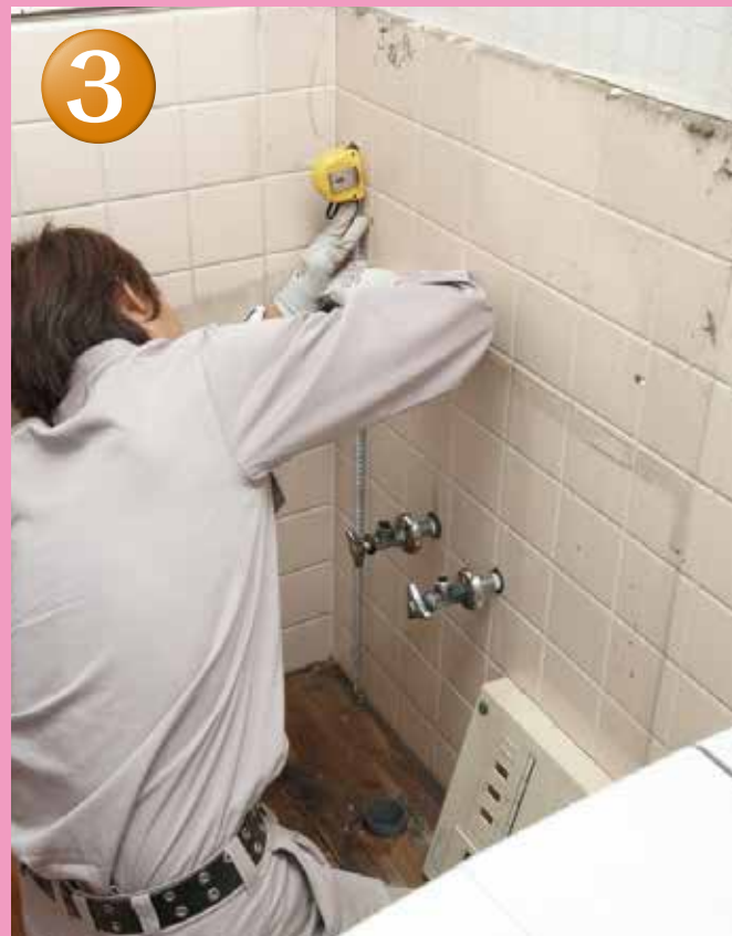
壁クロス貼り
