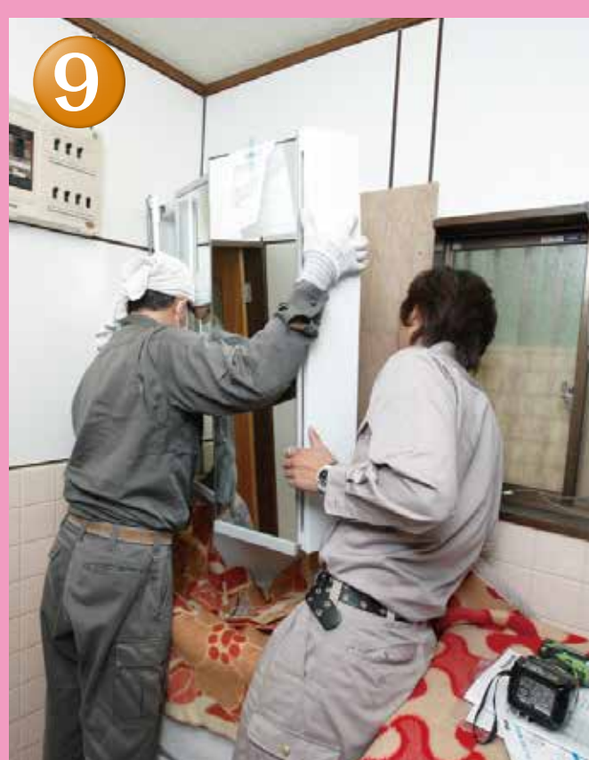
吊戸棚取付け
