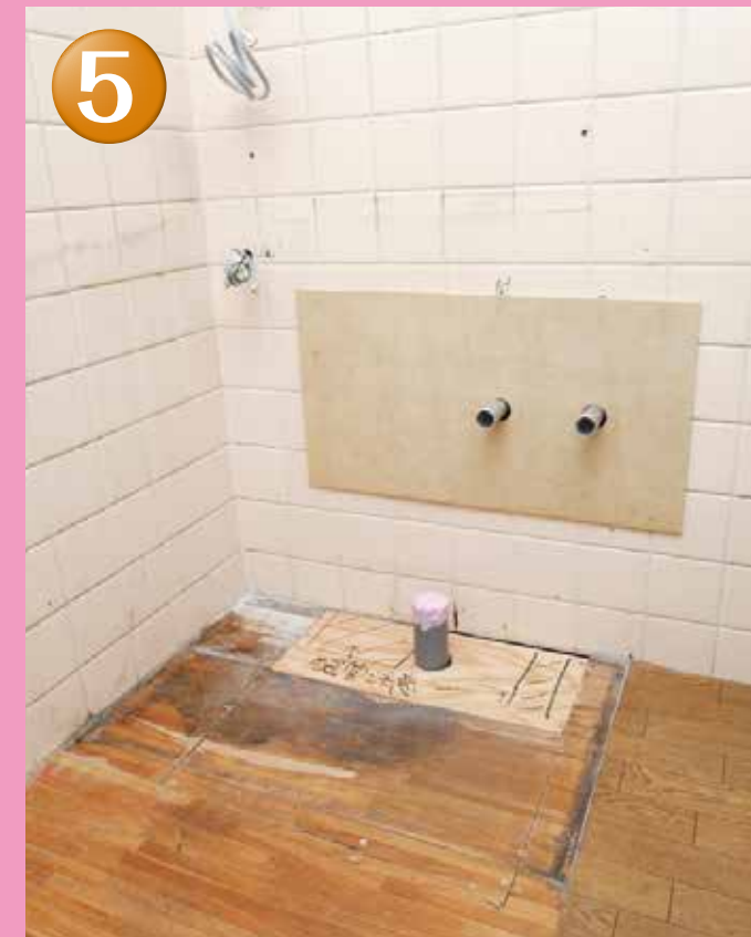
壁・床貼り完了
