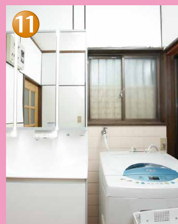
洗濯機据付け
